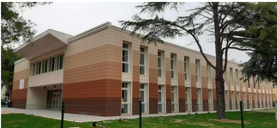
Rivestimento della facciata ventilata in gres porcellanato a manutenzione zero
